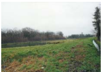
Station par lagunage de Jouy-le-Potier
